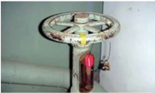
▲圖15.與反應爐連接的配管閥以鑰匙與鐵鍊封鎖，使無法開啟
