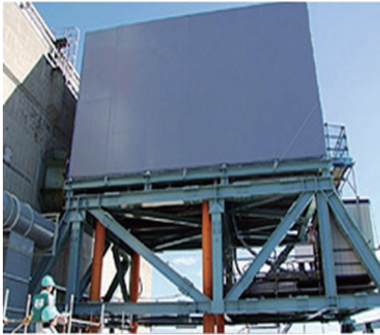
▲圖10.吊裝熱交換器本體的千斤頂
