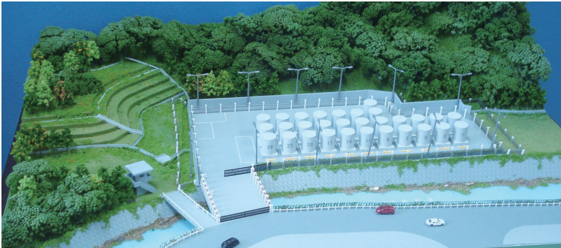
▲ 核一廠用過核燃料乾式中期貯存設施模型
