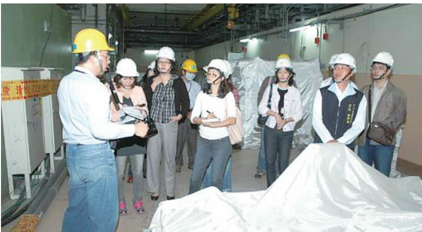
▲ 核四廠安全監督委員巡查2號機反應器廠房及汽機廠房施工現況
