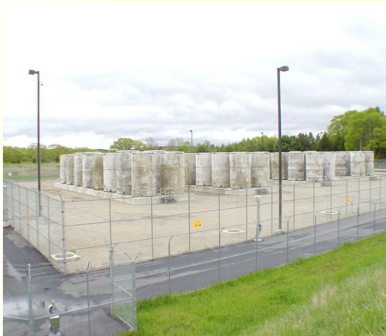
美國Maine Yankee 核電廠乾式貯存設施
