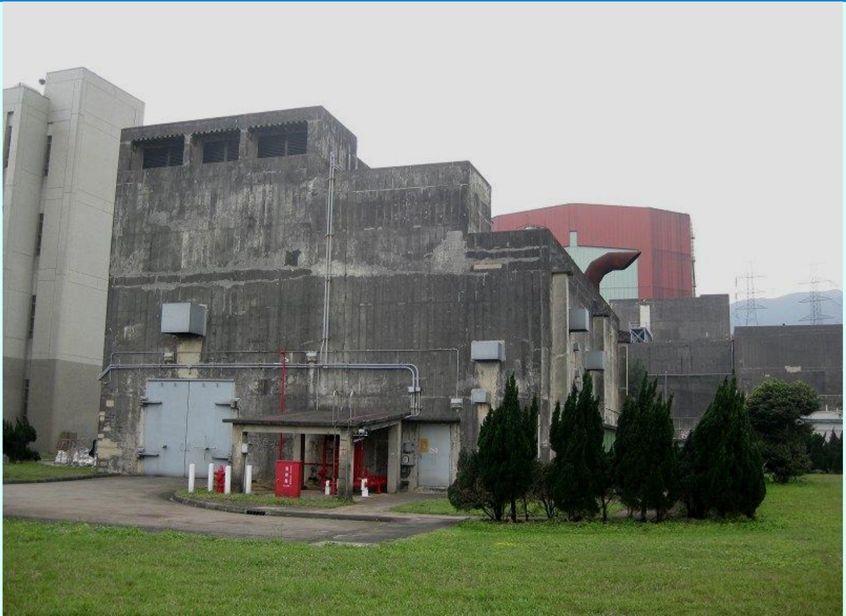
第5號柴油發電機廠房
